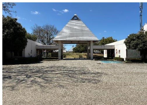
【事務室前エントランス】
